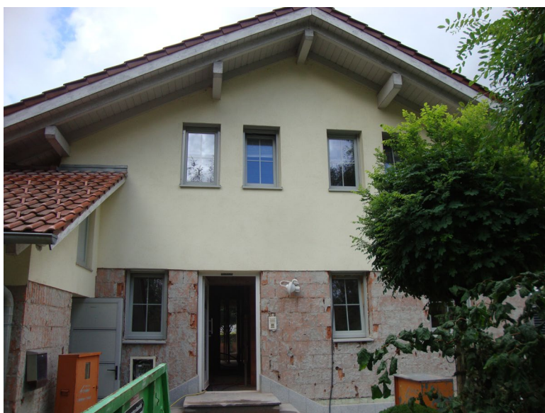
Abb. 1: gebäudeerhaltend: Durchführung von Sofortmaßnahmen (© Blei-Institut)
