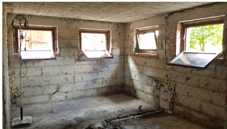
Abb. 2: Entkernungsmaßnahmen Keller (© Blei-Institut)
