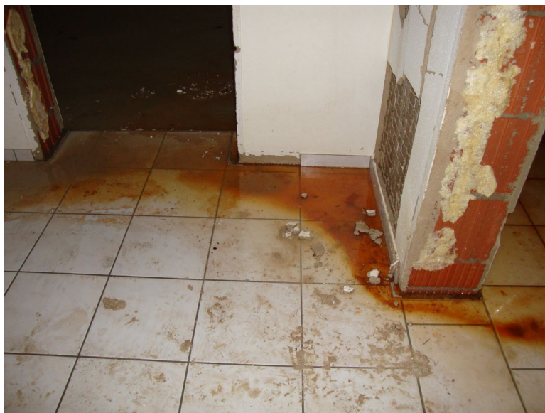
Abb. 3: sofortige Aufnahme von Ölverschmutzungen (© Blei-Institut)
