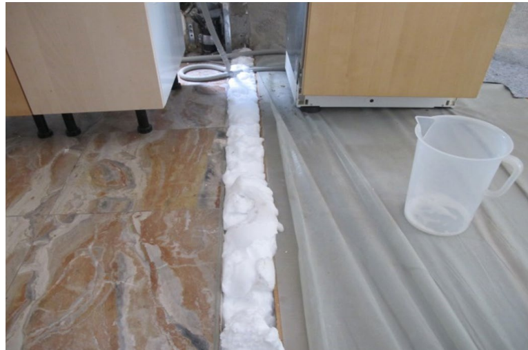
Abb. 7: Schaumverfahren auf Wasserstoffperoxidbasis (© Blei-Institut)
