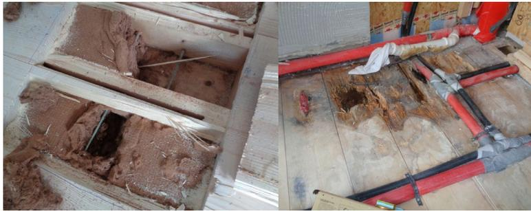
Abb. 11: Nasse Holzfaser-Dämmung mit Befall durch den Weißen Porenschwamm im 1. OG führt zum Rückbau der tragenden Deckenkonstruktion [Quelle: Blei-Institut GmbH]
