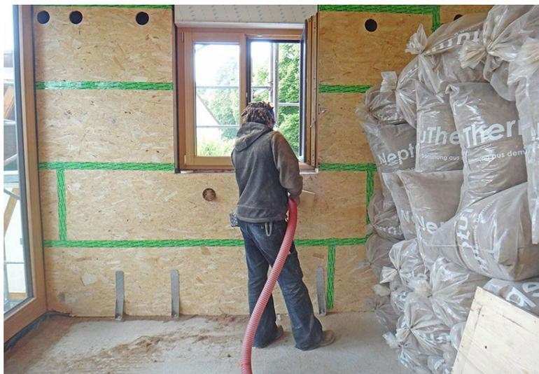
Abb. 3: Einblasen von Dämmung [Quelle: NeptuGmbH]
