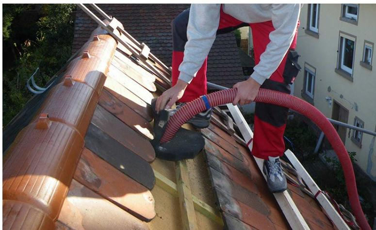
Abb. 1: Einblasen von Dämmung [Quelle: NeptuGmbH]
