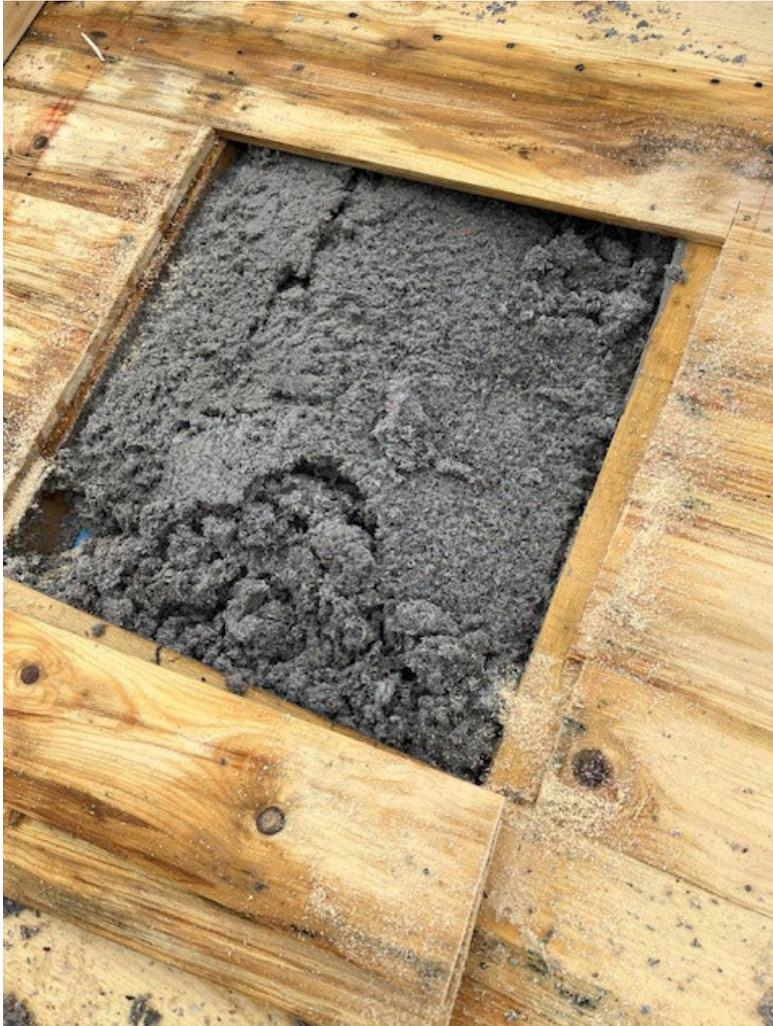
Abb. 10: Nasse Einblas-Dämmung im Satteldach macht den kompletten Rückbau der Dachkonstruktion notwendig [Quelle: Blei-Institut GmbH]
