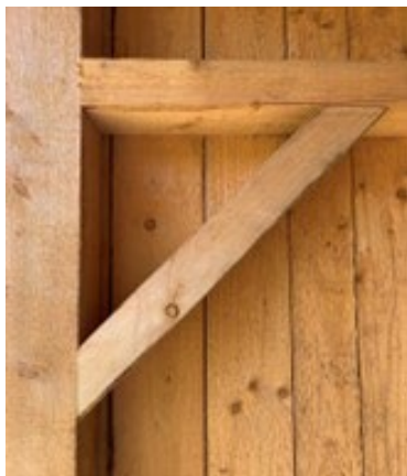
Abb. 8 oben und Abb. 9 unten: Carport aus Käferholz (Quelle: eigene Aufnahme)
