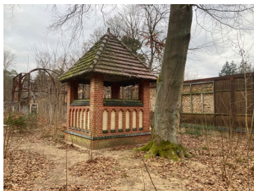
Abb. 7: Pump- und Wasserkraft-Häusschen (Quelle: M. Blei)
