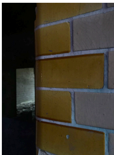
Abb. 8: Abgerundete Fliesenkannten an Wänden und Säulen erleichterten die Reinigung (Quelle: M. Blei)
