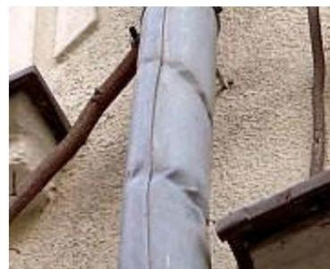
Abb. 9: Schaden durch Kraftentwicklung der Pflanzen (Quelle: [www.fassadengruen.de](http://www.fassadengruen.de))
