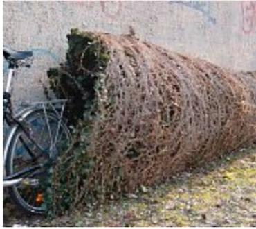
Abb. 10: Herabgefallene Fassadenvegetation durch mangelnde Befestigung (Quelle: [www.fassadengruen.de](http://www.fassadengruen.de))
