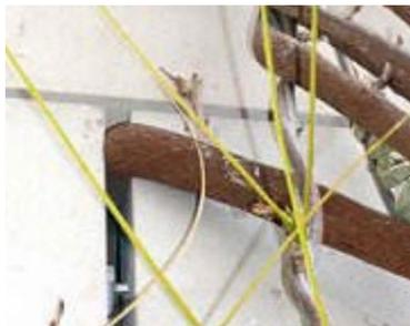
Abb. 7: Schaden durch Einwachsung in Fuge (Quelle: [www.fassadengruen.de](http://www.fassadengruen.de))
