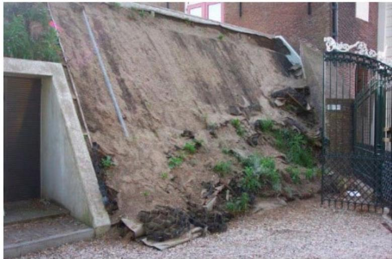
Abb. 5: Abgerutschtes begrüntes Steildach, Schadensfall durch mangelnde Schubsicherung (Quelle: Optigrün international AG)
