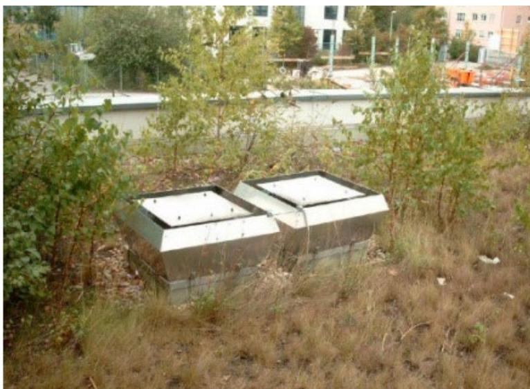
Abb. 6: Fremdbewuchs, Schadensfall durch mangelnde Pflege (Quelle: Optigrün international AG)
