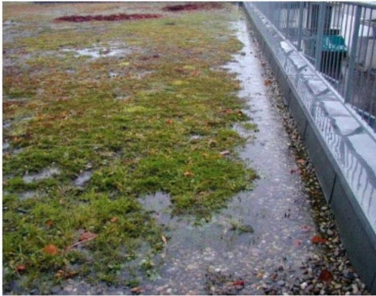
Abb. 3: Aufstauendes Wasser, Schadensfall durch ungeeignete Drainage (Quelle: Optigrün international AG)
