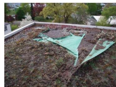
Abb. 4: Winderosion, Schadensfall durch ungenügende Verwehssicherheit (Quelle: Optigrün international AG)
