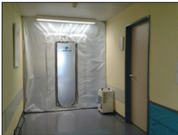
Abb. 4: Sanierungsarbeiten am Gebäude, mit Staubschutzwänden
